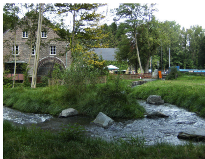
Fischtreppe Lüttelforst NAGREWA
