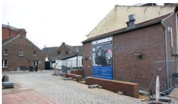
Tegelen - Restauratie wasplaats Engerbeek
