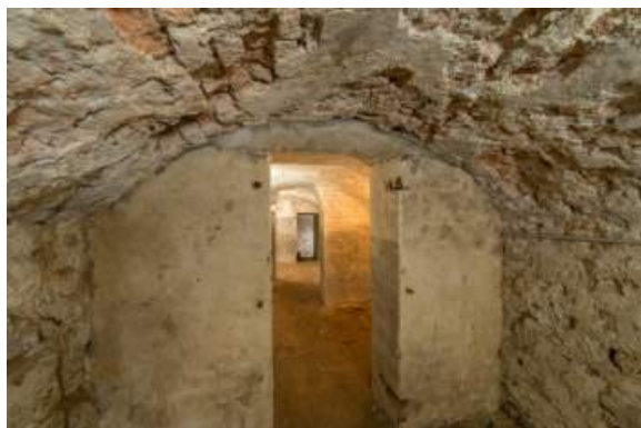
Brüggen - Restauratie Kazematten
