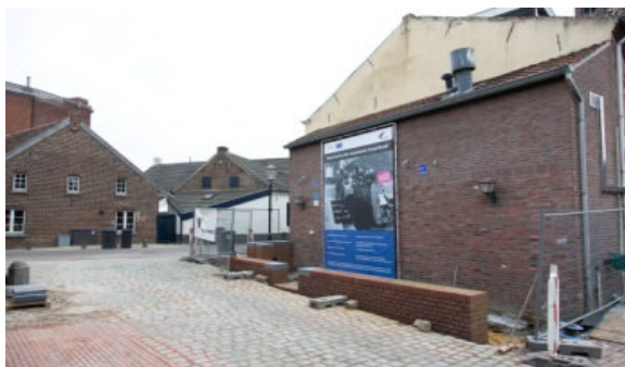
Tegelen - Restauratie wasplaats Engerbeek
