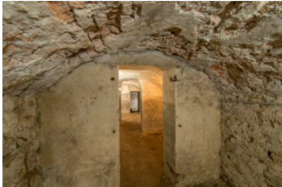
Brüggen - Restauratie Kazematten
