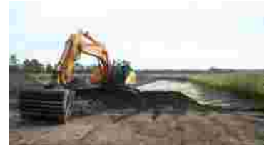
Verwijderen bovenlaag Reigersbroek
